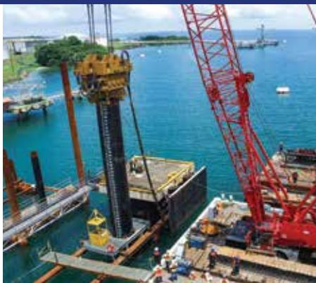
El proyecto consistió en el diseño, suministro y construcción de nuevos postes de amarre y atraque para la rehabilitación y modernización de la terminal sur, que incluye la hincada de una serie de monopilotes de 2 m de diámetro y con pesos superiores a 90 toneladas cada uno, así como la construcción de la superestructura e instalación de las pasarelas de conexión.
