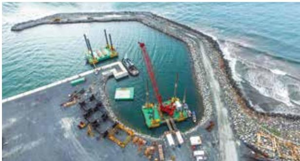
Equipo Jack up de 400 ton de capacidad y con una grúa de 300 ton de capacidad en cubierta.
