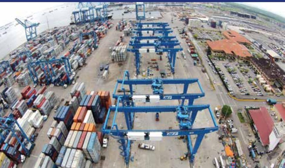
Manzanillo International Terminal. El proyecto consistió en la construcción del primer sistema de grúas portacontenedores automáticos en América Latina. IMI construyó un kilómetro de vías para el sistema de traslado de las grúas portacontenedores; prefabricó e hincó 450 pilotes prefabricados de hormigón, junto con la instalación de todo el sistema electromecánico que conlleva la superestructura del sistema (rieles, viaductos eléctricos, sistemas de drenaje, entre otros).
